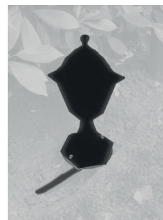
Installazione della luce del giardino Garden light installation
